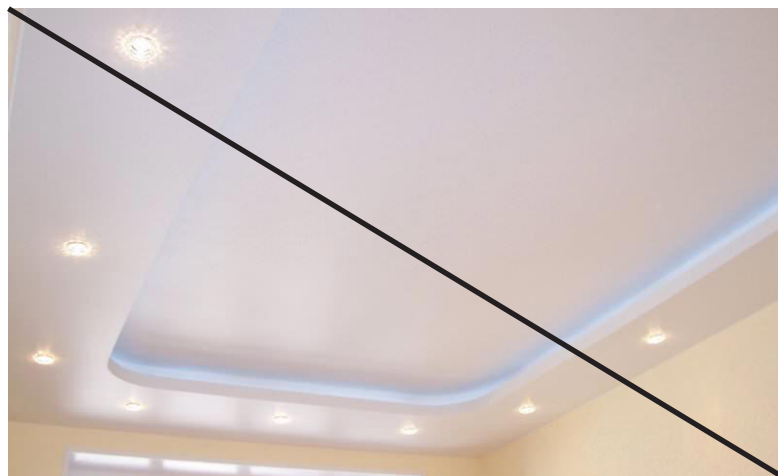
Плохо Многоуровневые гипсокартонные конструкции
