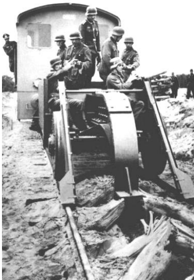
Уничтожение немцами ж.д. путей при отступлении, 1943 г.
