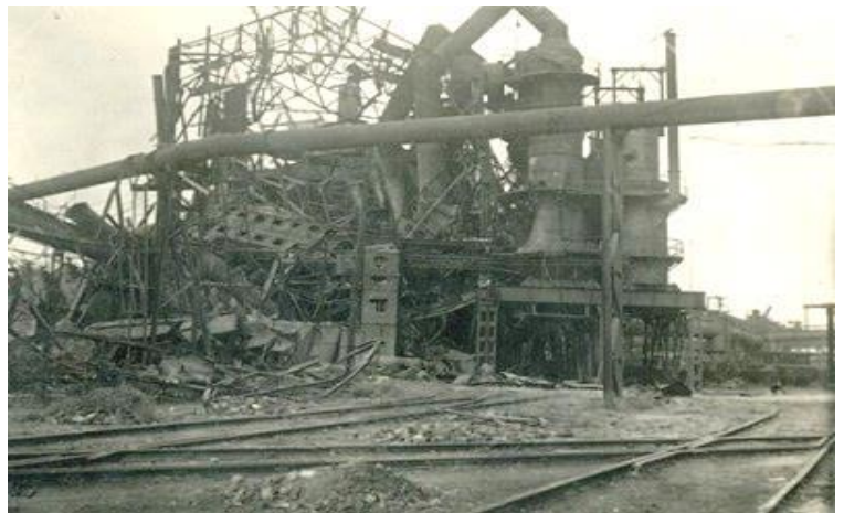
Разрушенная домна завода имени Ильича
