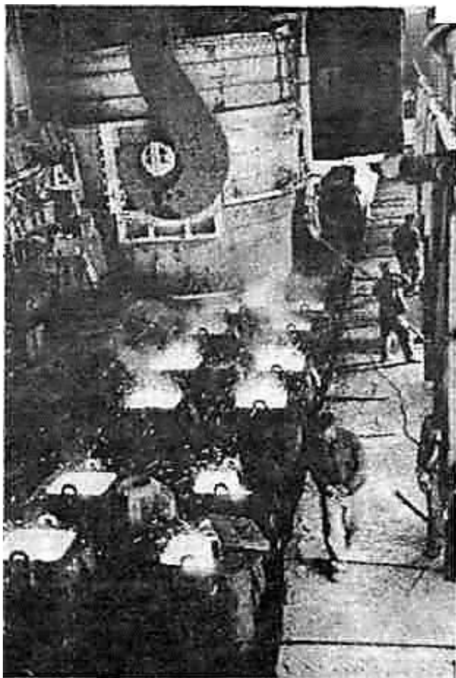
Разливка стали в мартеновском цехе № 1 Макеевского металлургического завода, 1949 г.
