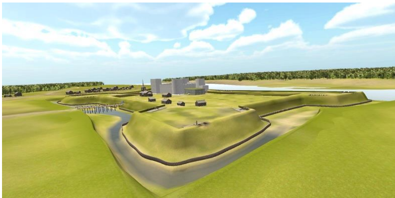
Бастионное земляное укрепление
