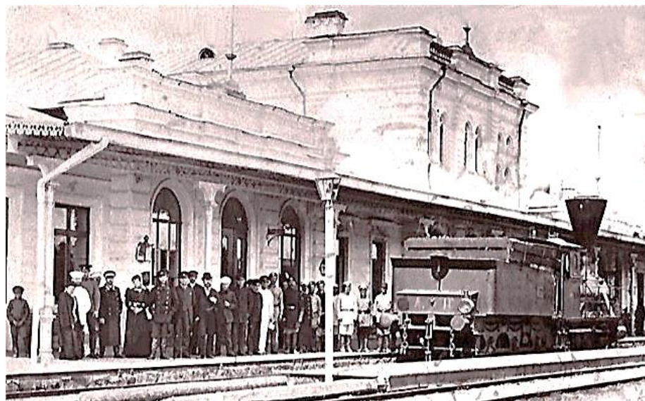
Ясиноватая, железнодорожная станция
