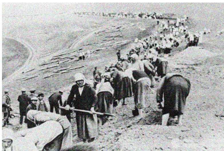
Строительство линии обороны на Донбассе
