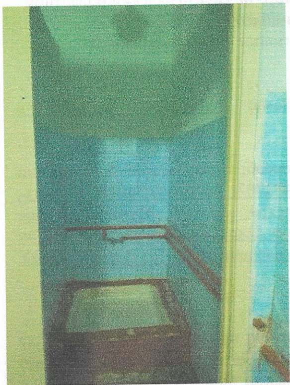
Рис.1 Состояние объекта «До».
