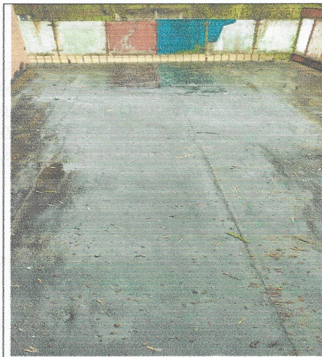
Рис.1 Состояние объекта «до»
