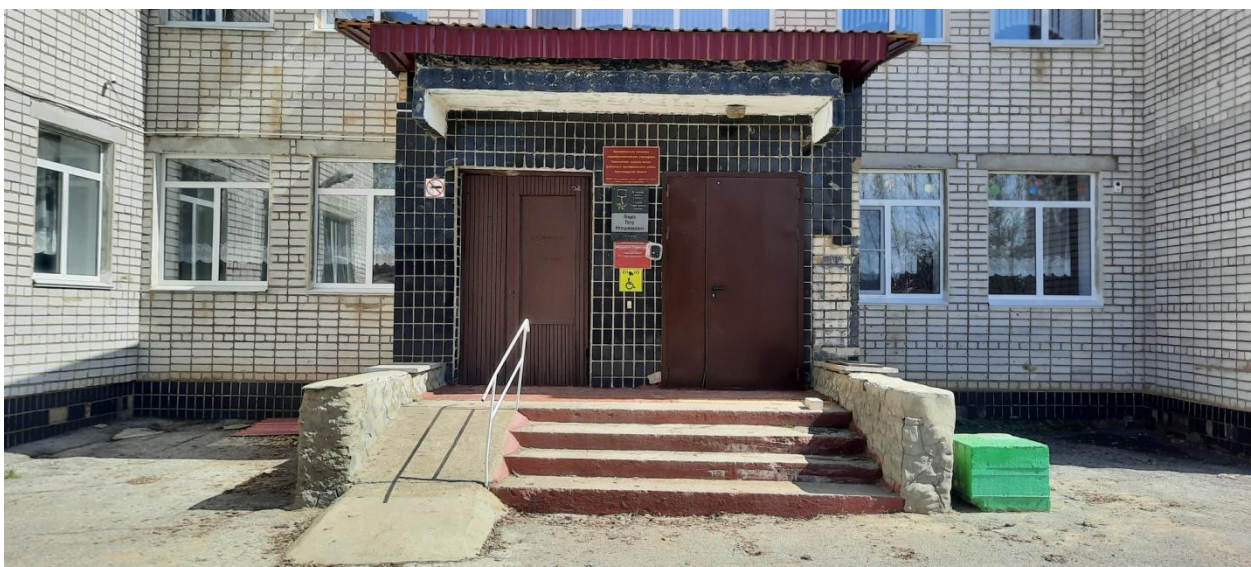
Рис. 1 Состояние объекта «До».
